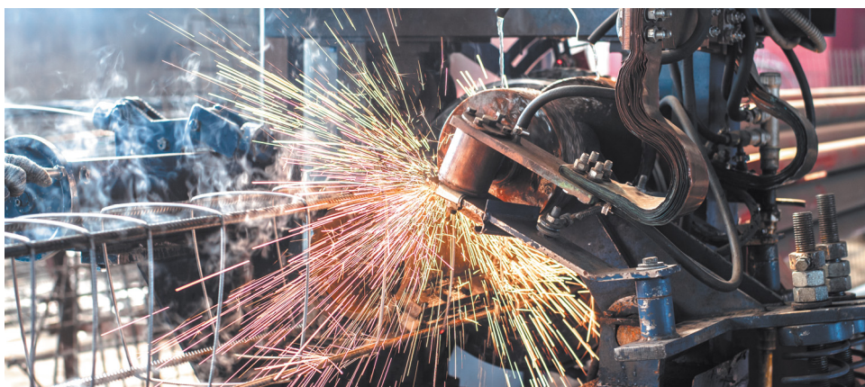
В ГК «ПрофСтрой» установлено современное оборудование для производства свай
