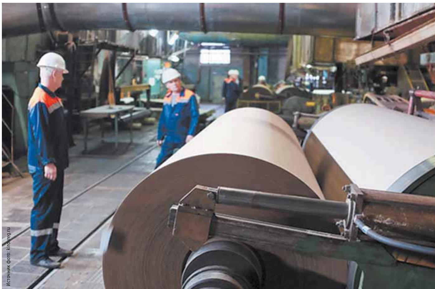
СФК удалось восстановить производство в Мурыгино. Мощности площадки постепенно реконструируются
