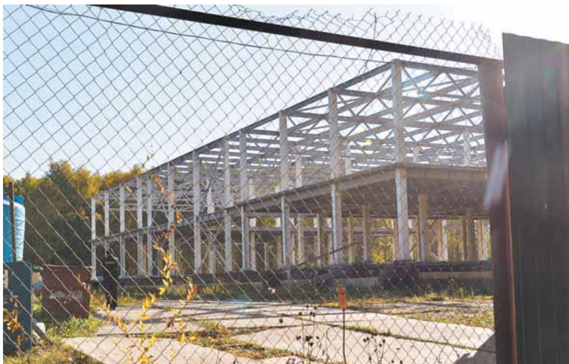
Работы на стройплощадке в парке у Дворца пионеров пока не начались
