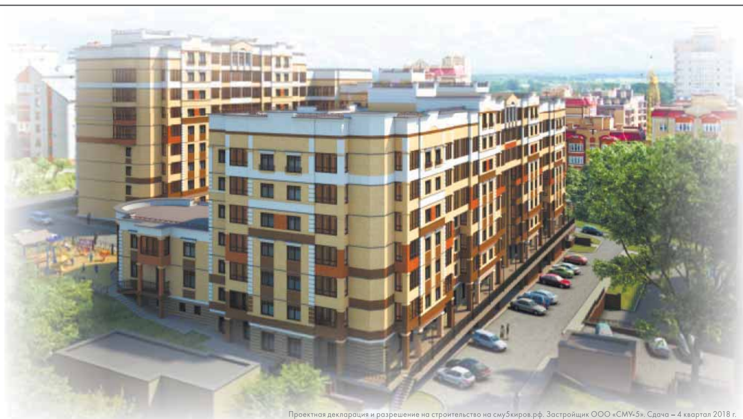
Проектная декларация и разрешение на строительство на smu5киров.рф. Застройщик ООО «СМУ-5». Сдача – 4 квартал 2018 г.
