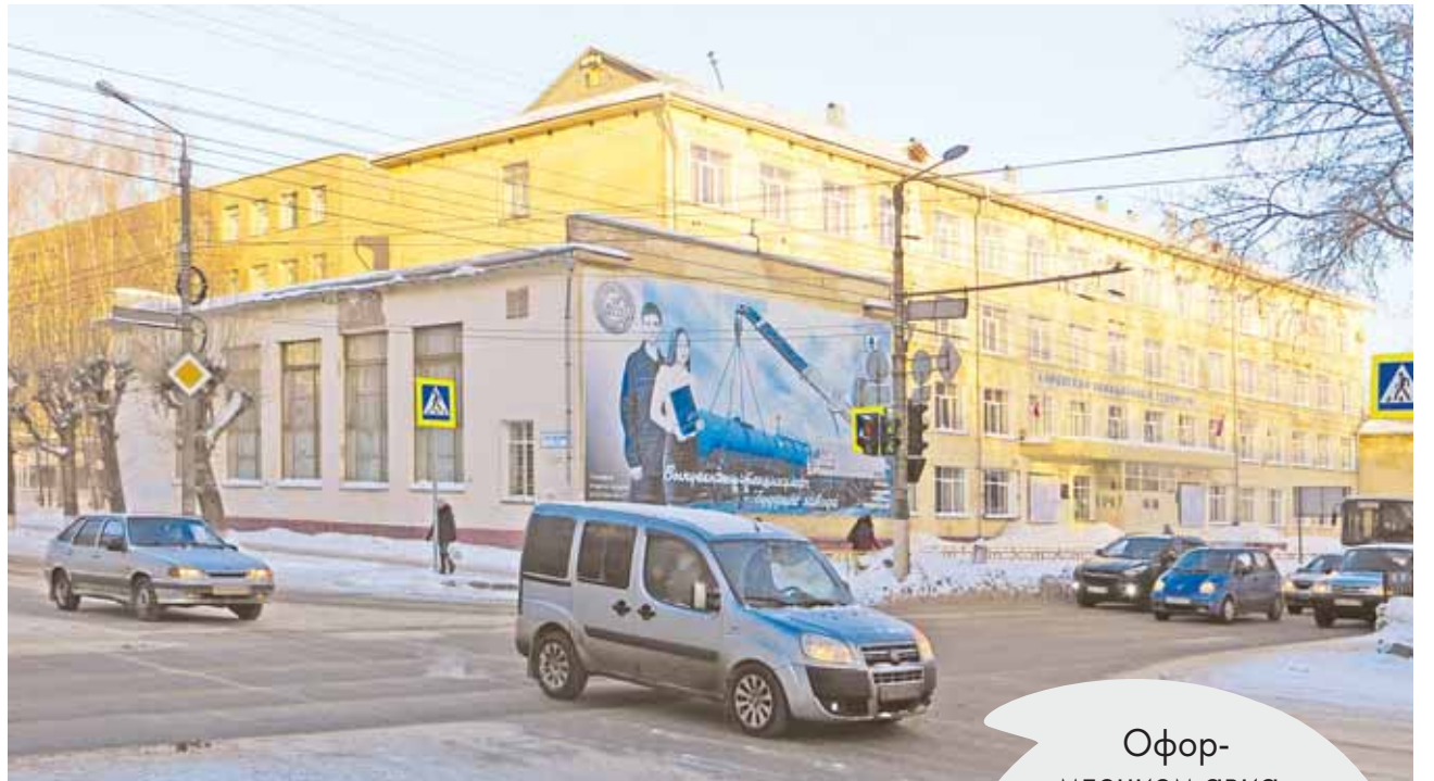
Аргумент чиновников: «Зданию техникума нужен срочный ремонт, нам не до эстетики»
