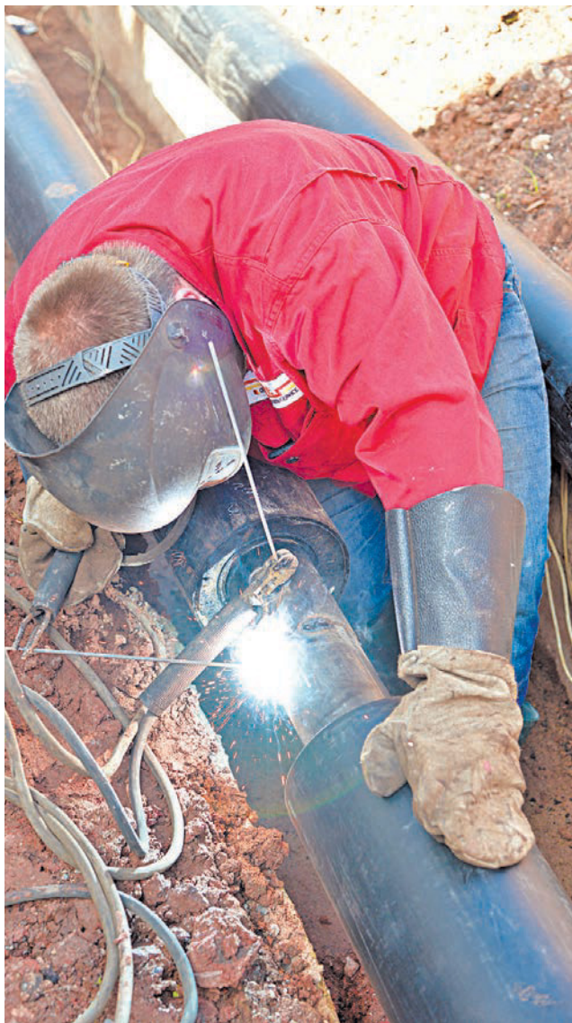
При прокладке трубопроводов с системой ОДК мало состыковать две стальные трубы. Нужен опыт и спецоборудование.
