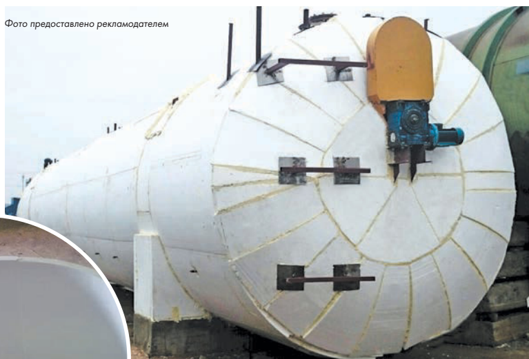
С помощью скорлупы можно обеспечить теплоизоляцию даже цистерн
