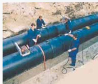
Тепло- и гидроизоляция сварных стыков
